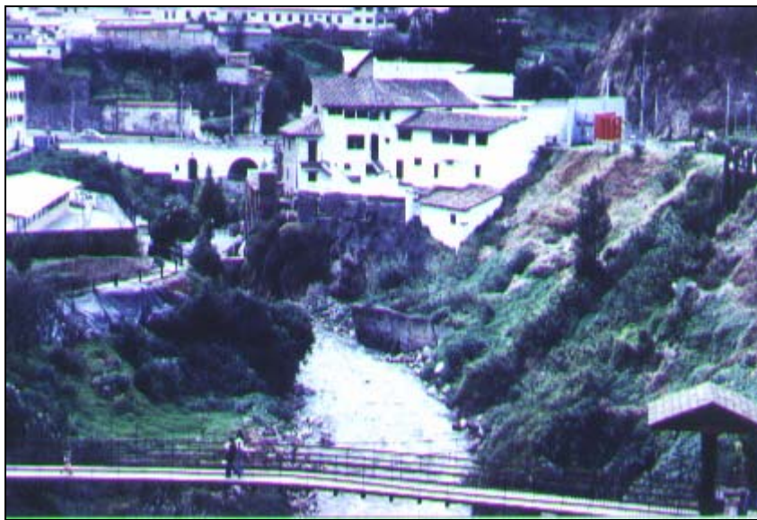
Puente sobre el Río Machángara, parque Lineal
