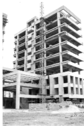
Avance de la obra a diciembre 2003
