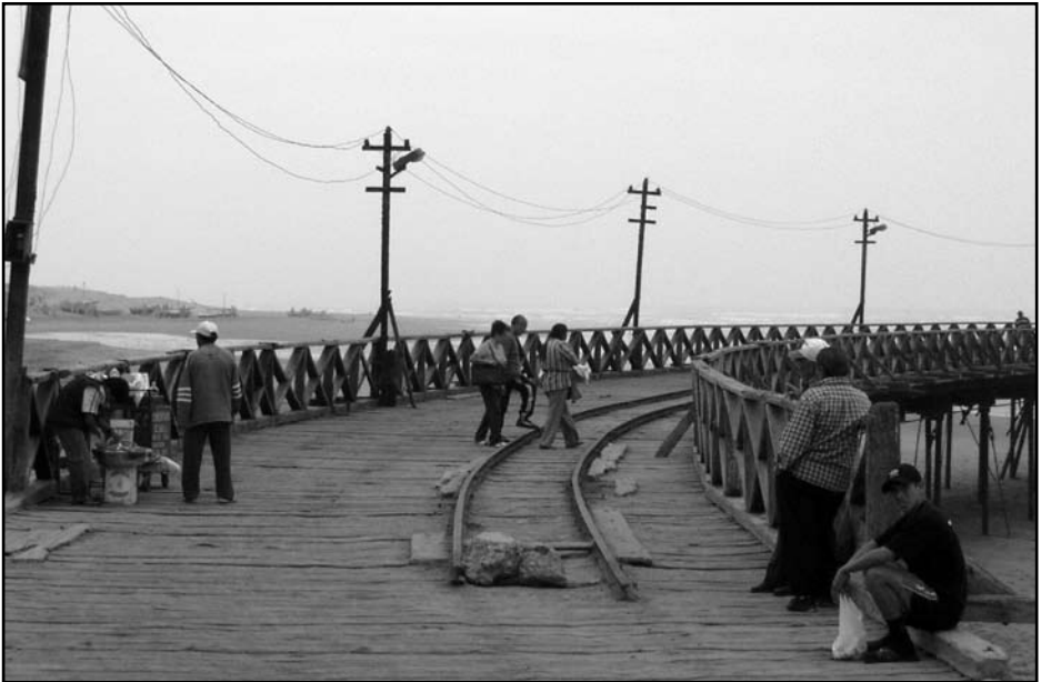
Uso actual del antiguo puerto de Pimentel
