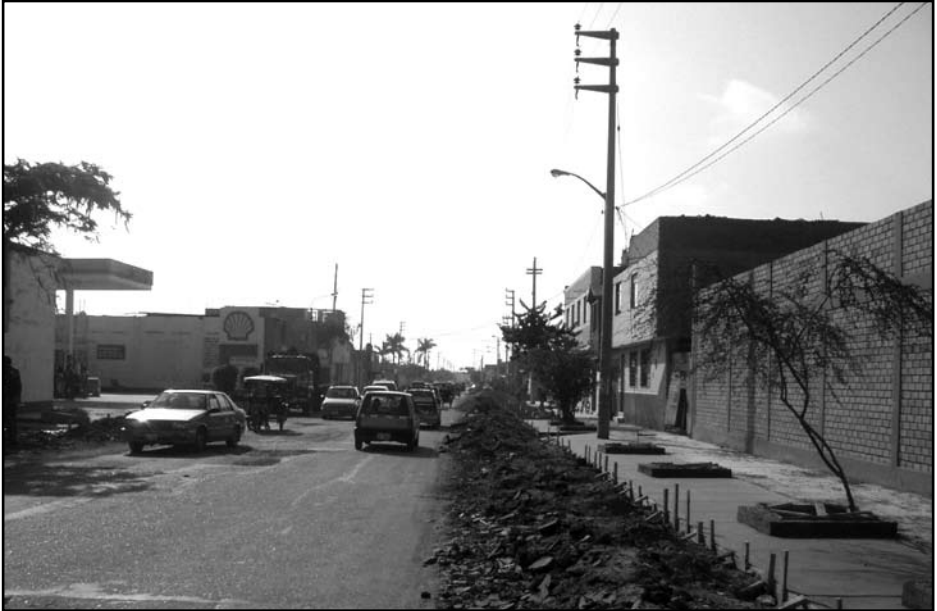
Construcción de calles, veredas y alamedas
