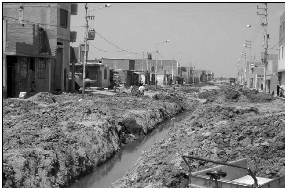
Construcción de calles, veredas y alamedas
