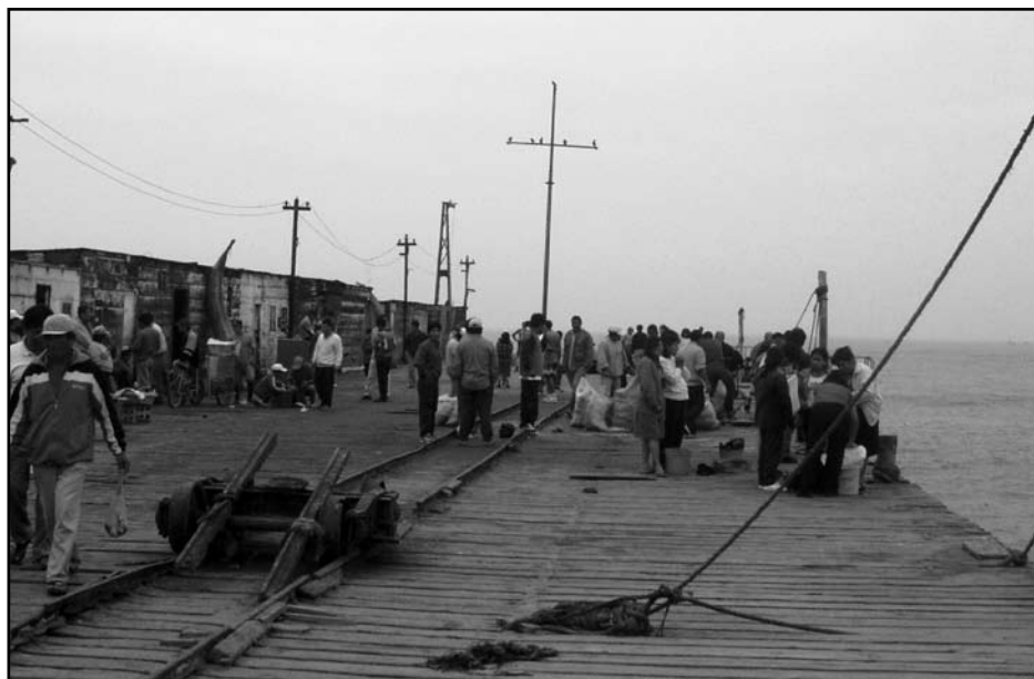
Uso actual del antiguo puerto de Pimentel
