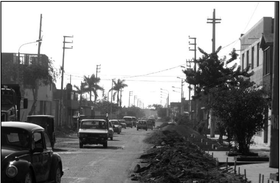
Construcción de calles, veredas y alamedas
